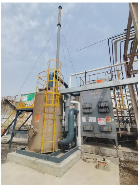
罐区损耗废气治理设施（二级活性炭吸附）
