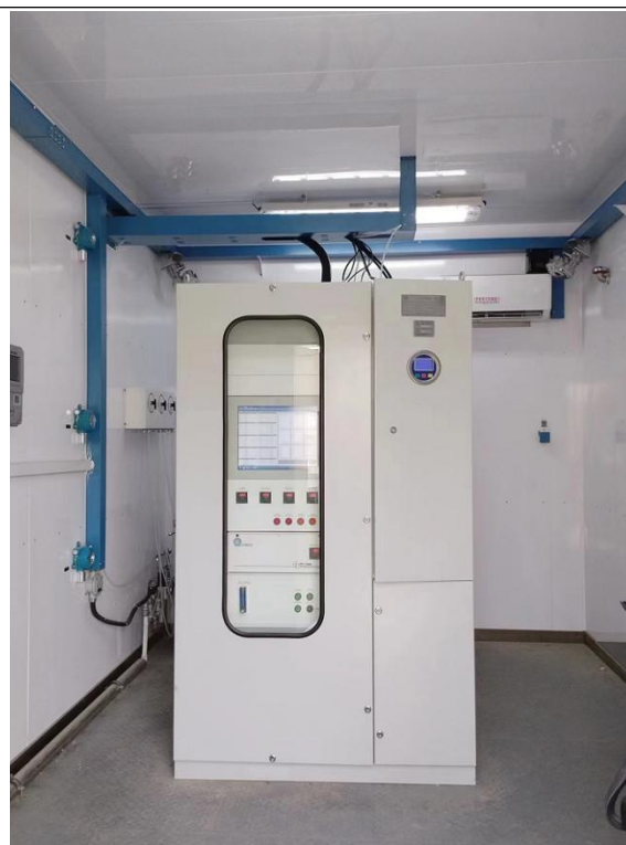
焚烧炉废气在线系统内部设备
