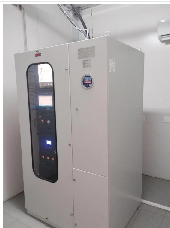
危废贮存间废气在线设备间内部设备
