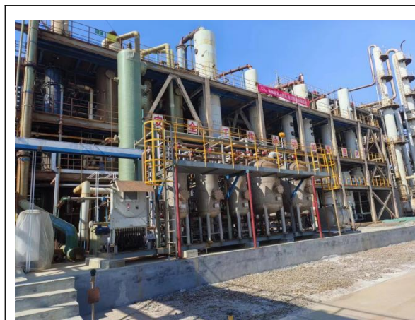
氯化废气用废气治理设施（水洗+碱洗+二级水冷+气液分离+一级吸/脱附+二级吸/脱附）
