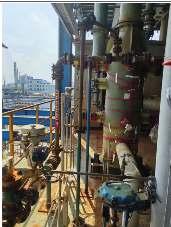
反吹废气等用废气治理设施（碱洗塔）
