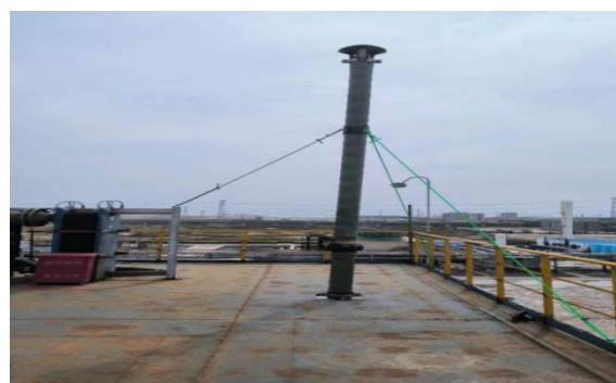
含盐废水精制装置氧化废气排放口
