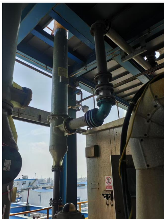
氧化后废气用废气治理设施（碱洗塔）
