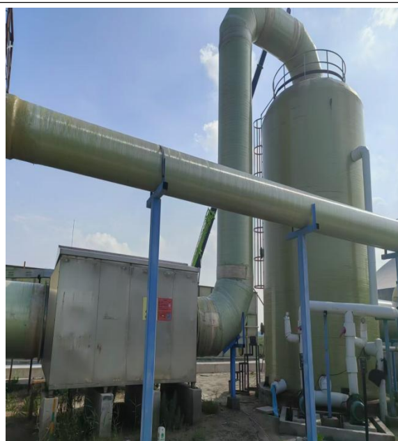
依托污水处理站用废气治理设施（碱洗+生物除臭+活性炭）
