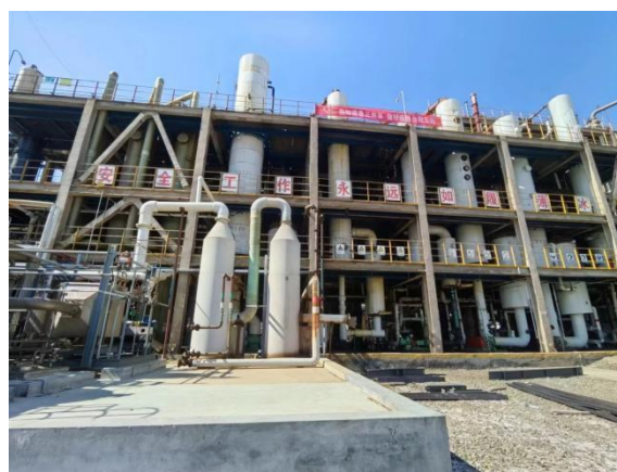
环化塔不凝气等用废气治理设施（水洗+碱洗）
