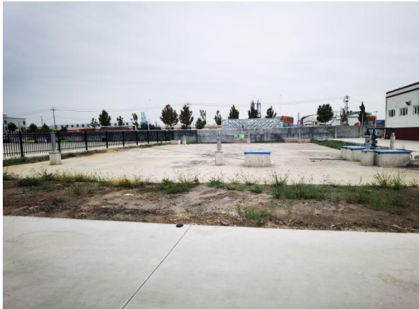
图 4.2-1 事故水池及雨排切换阀
