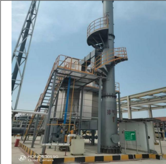
图 4.2-6 油气回收装置排气筒（依托）
