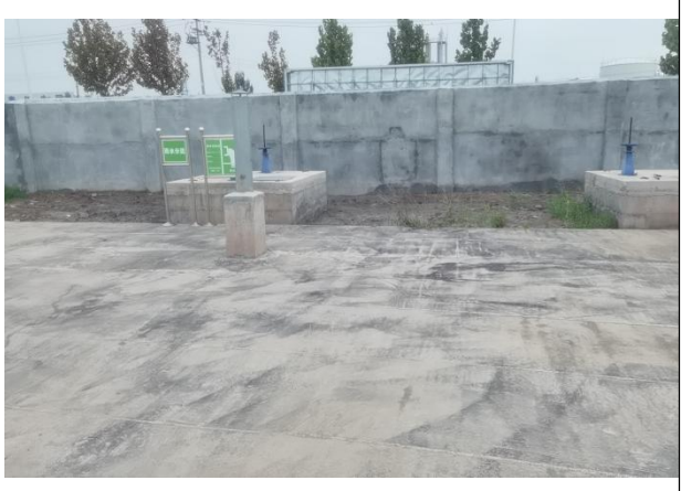
图 4.2-1 事故水池及雨排切换阀
